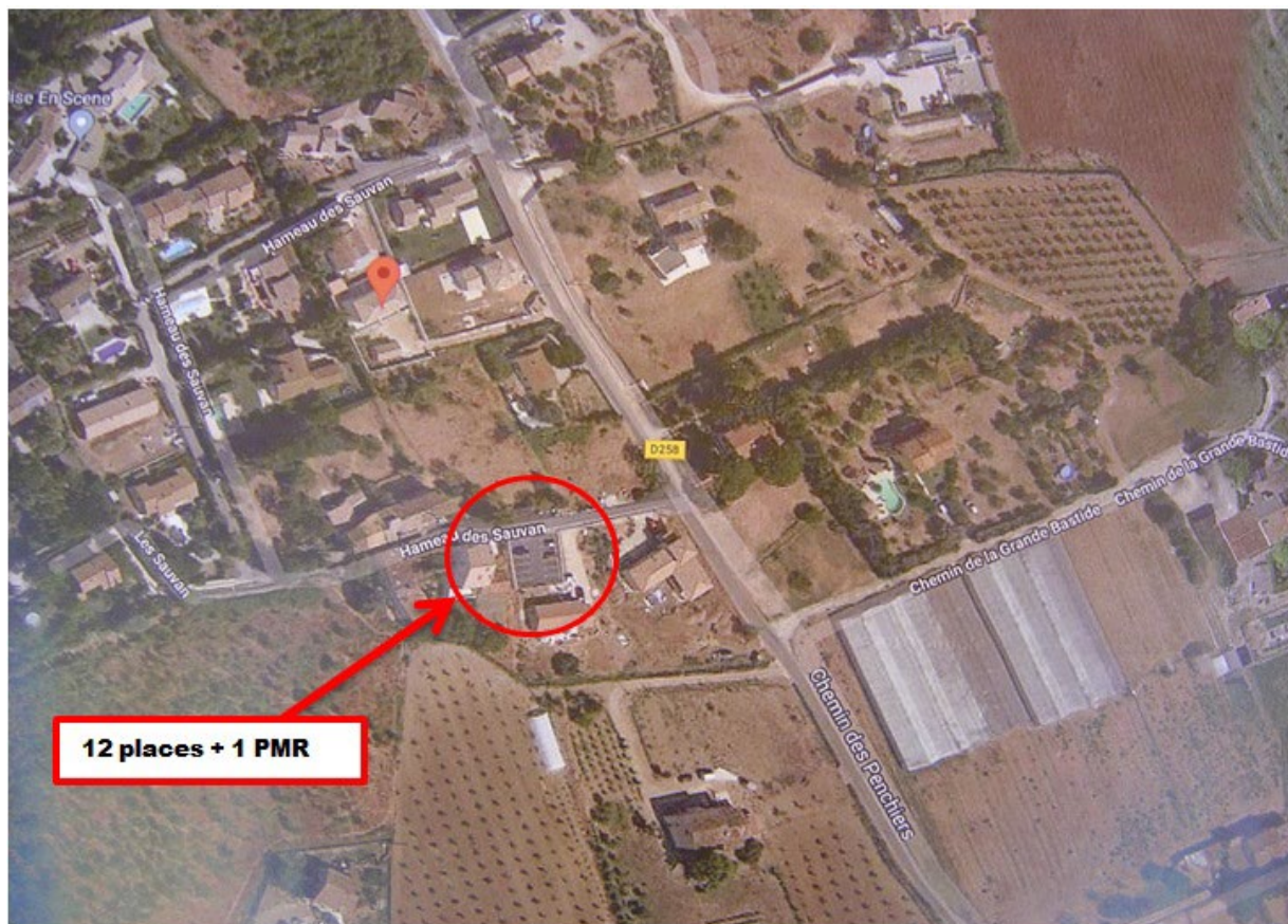
Parc de stationnement N°5 : Les Sauvans
