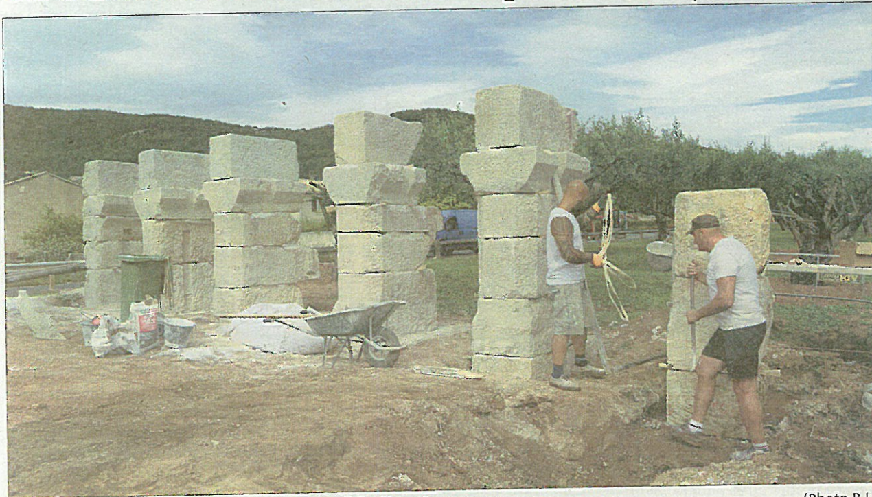
Le chantier de reconstitution des presses à huile est en cours.
