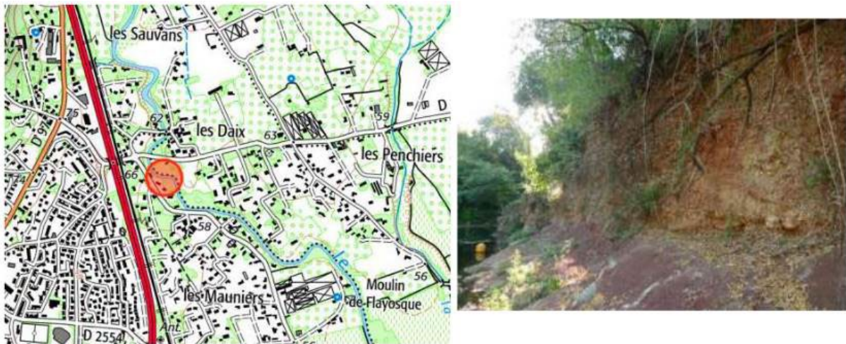
Site de recréation de berge à Solliès-Ville du fait de son érosion (source : PAPI Gapeau)
